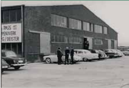
Das Werk Rodenberg kurz nach der Erbauung.
